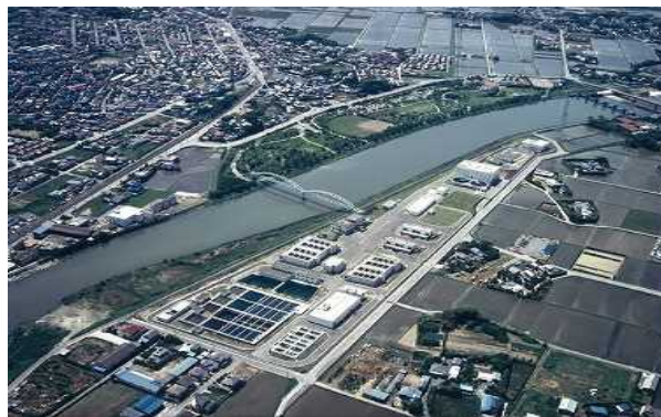
十日市場浄水場 (処理能力 60,000 m 3 /日)
