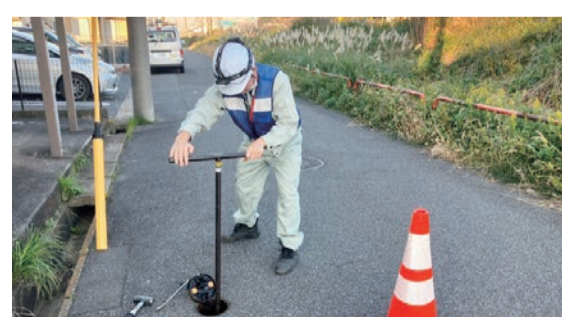
▲(漏水修繕) 漏水箇所を修繕する際、修繕の状況により、断水する場合があります。断水影響範囲にお知らせした後に、断水させます。
