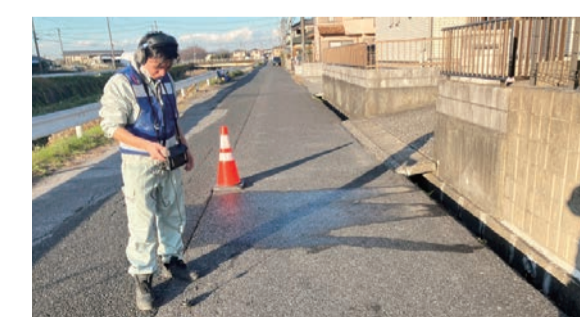
▲(漏水修繕) 漏水していると音がします。その音を聞いて、漏水箇所を探しています。
