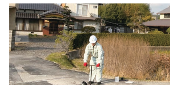
▲(更新工事) 新しく布設した水道管内部を水道水で流して洗う洗管作業をしています。
