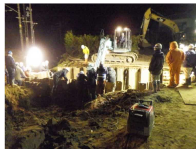
送水管復旧の様子（富津市）
